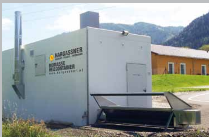
Enkelvoudige verwarmingscontainer bij woningbouw.
